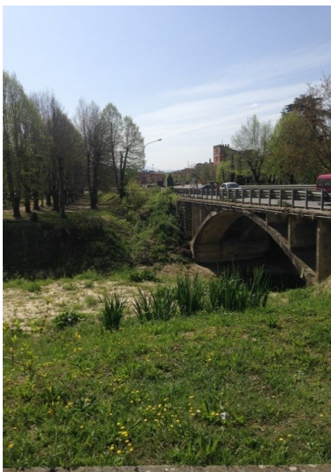
Ponte Ombrone Buonconvento
