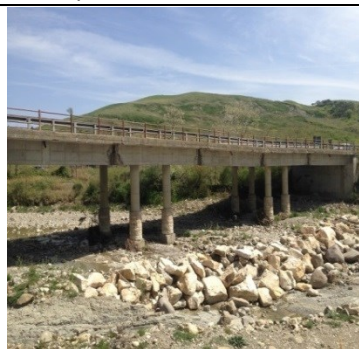
Viadotto sul fiume Paglia
