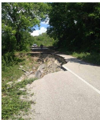
Strada di collegamento Radicondoli Castelnuovo Val di Cecina
